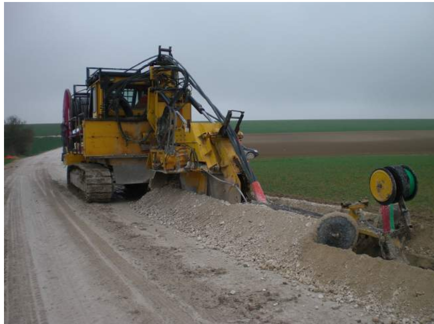
Photo 17 : Pose mécanisée de câbles électriques (Source : BE Jacquiel et Chatillon)
