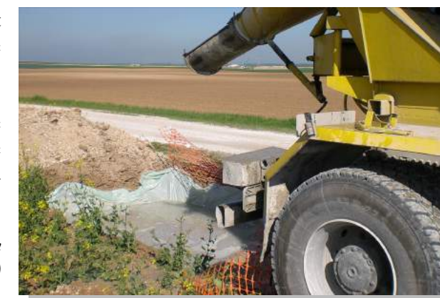
Photo 26 : Exemple de récupération des laitances de béton (Source : BE Jacquel et Chatillon)
