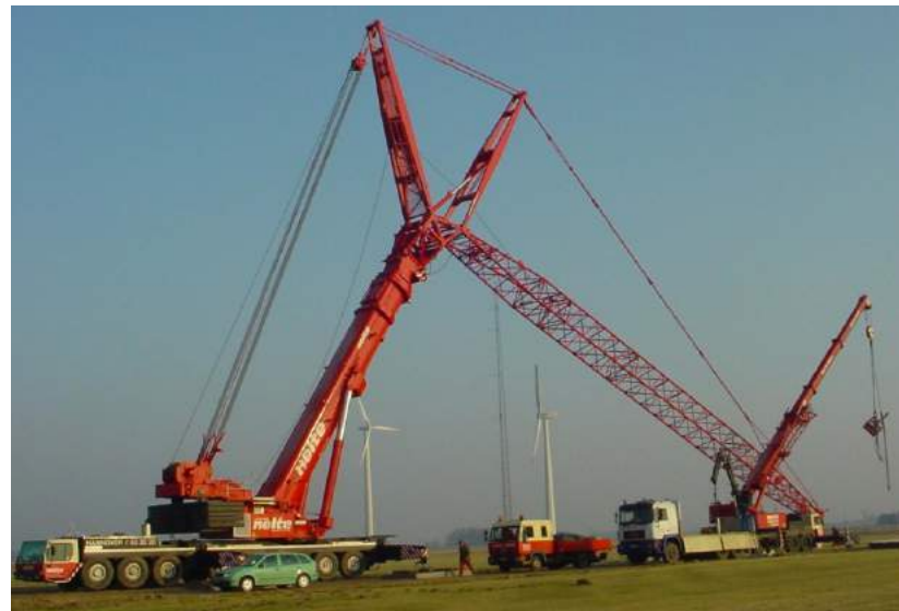
Photo 12 : Grues nécessaires au montage des aérogénérateurs et à l'assemblage des rotors (Source : NOLTE)
