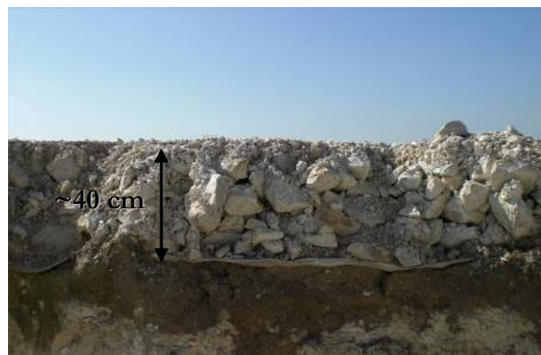
Photo 9 : Type de remblais utilisés pour le renforcement des chemins d'accès (Source : BE Jacquiel et Chatillon)
