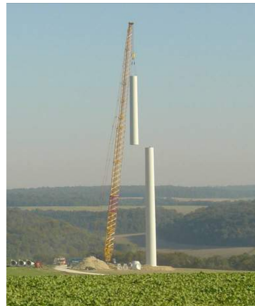
Photo 5 : Assemblage d'un mât d'éolienne (Source : SENVION)
