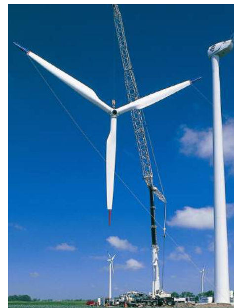
Photo 6 : Exemple de montage d'un rotor d'éolienne (Source : REpower)
