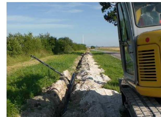
Photo 16 : Pose de câbles électriques et réalisation de tranchée à la pelle mécanique (Source : BE Jacquel et Chatillon)
